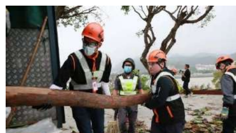
合力清理道路塌樹
